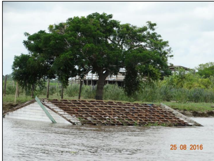
Figura 5. Casa de madeira dentro da água devido ter sido levada por processo de solapamento de margem. Fonte: Pará (2016).
