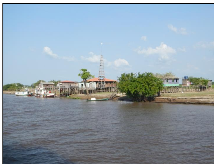
Figura 7. Moradias de madeira instaladas num terreno muito suscetível a erosão fluvial, comunidade São Braz.
