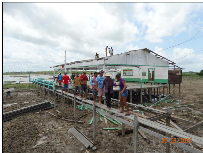
Figura 6. Casa de madeira, sobre palafitas, sendo desmontada, para que não seja mais ocupada, uma vez que apresenta risco muito alto de ser atingida pela erosão fluvial. Fonte: Pará (2016).
