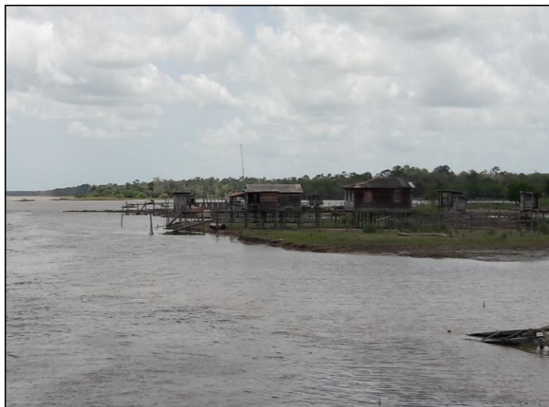
Figura 3. Comunidade de São Braz após o evento de Terras Caídas. Fonte: Pará (2016).
