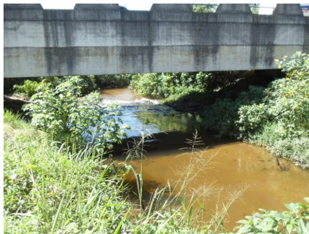
Figura 5 – Detalhe do Rio Santo António sob a ponte situada a 100m para jusante do traçado do Contorno. Notar a deposição de areia no leito e a seção hidráulica reduzida
