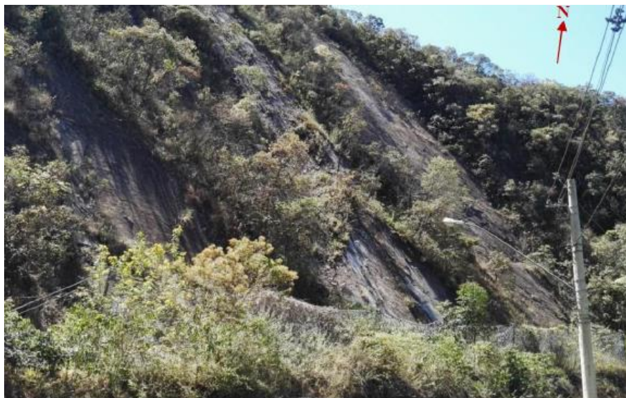
Figura 7 – À direita tem-se a visão geral do talude Mangabeiras exibindo cicatriz de ruptura planar segundo F1. À esquerda exibe-se detalhes da ruptura ao longo de F1.
