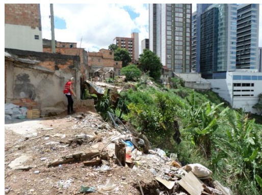
Figura 10 - Encosta após as demolições.
