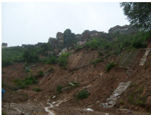
Figura 07 - Vista a partir da jusante.
