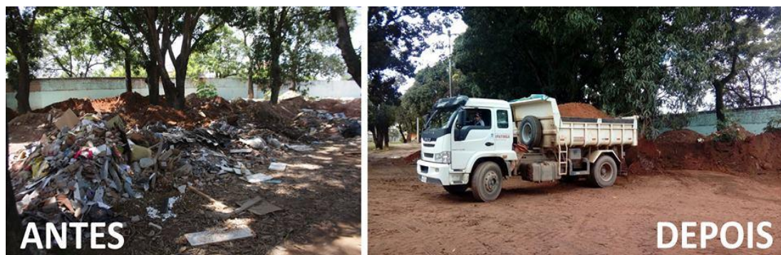
Figura 5 - Retiradas de RCD de Área no Bairro Cidade Nobre, em Ipatinga
