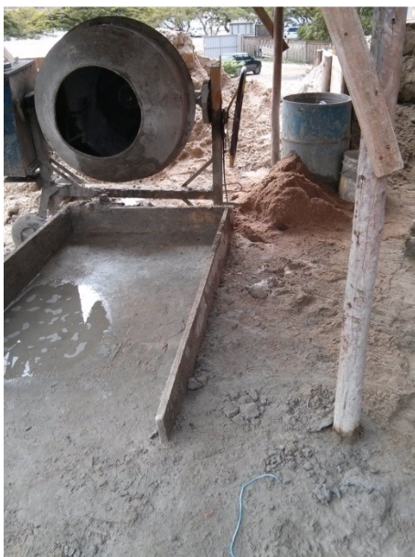
Figura 1. Produção das argamassas (a) Içamento do carrinho de mão (b).
