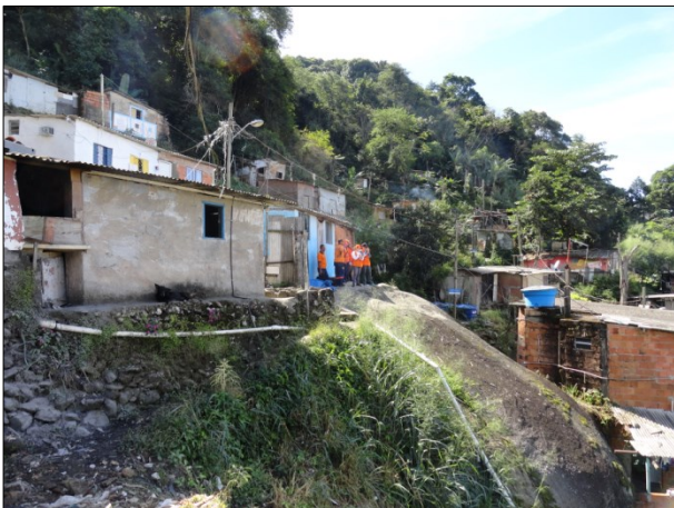
Figura 16. Vista da área da Vila Baiana em um dos pontos vistoriados. Notar a alta declividade do terreno.
