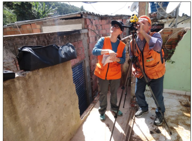
Figura 17. Utilização do telêmetro a laser para averiguação dos graus de inclinação.
