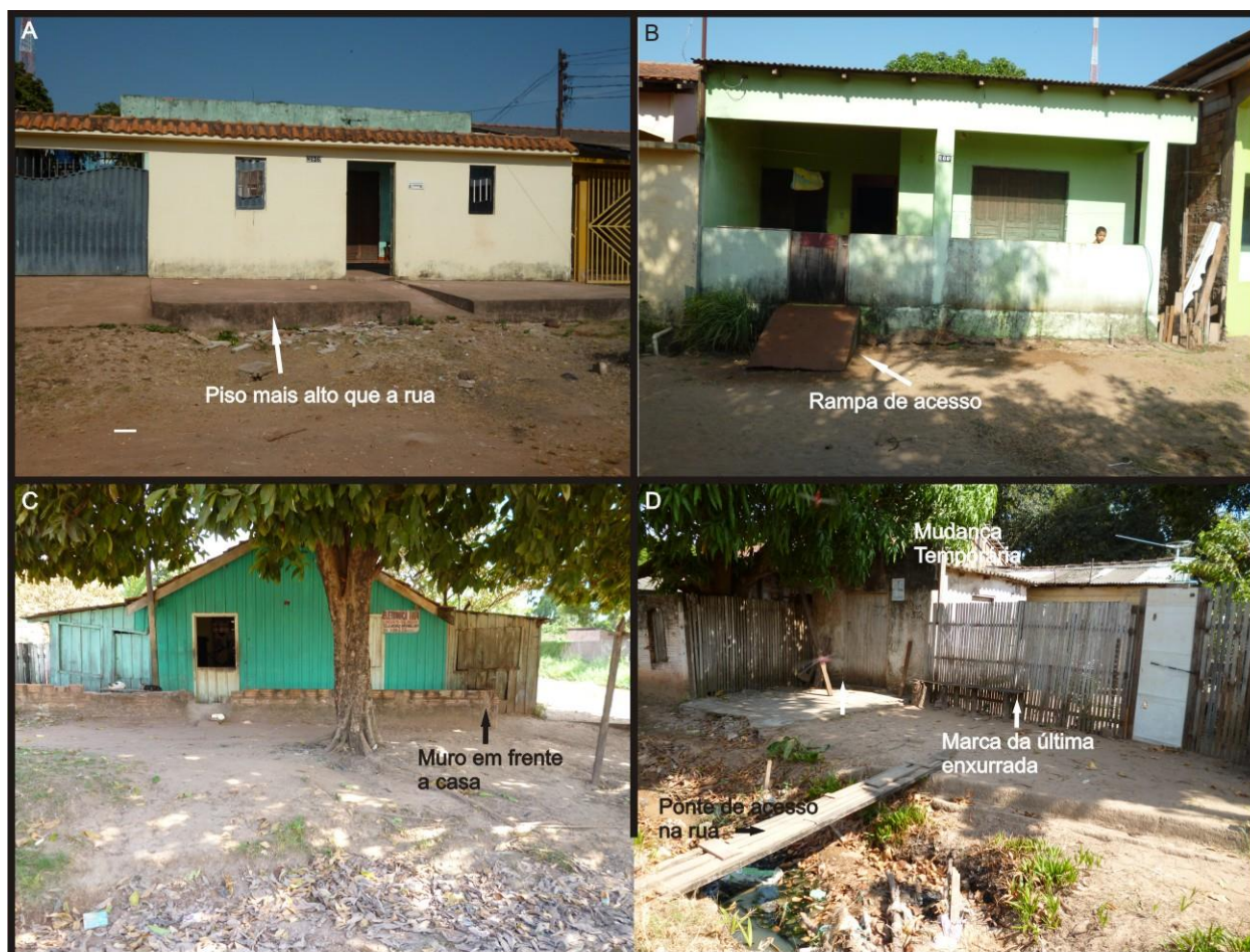
Figura 3. Exemplos de medidas estruturais utilizadas no bairro Interventoria (A) Calçada elevada em relação ao nível da rua; (B) Rampa de acesso à casa; (C) Mureta em frente à casa de madeira; (D) Ponte de acesso à casa por conta dos processos erosivos instalados após enxurrada.
