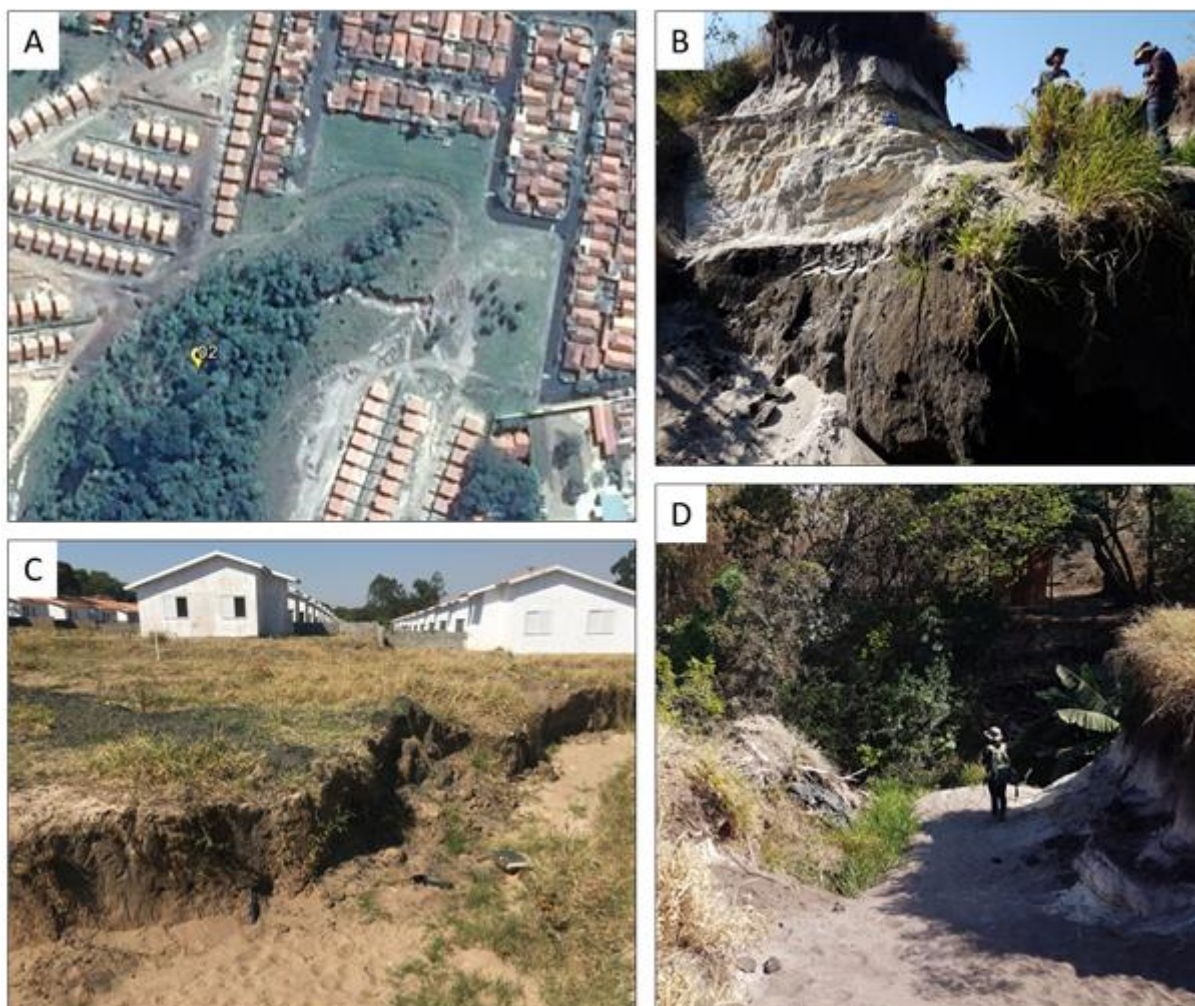
Figura 2. Ponto 1, em: A) Vista da proximidade da erosão com os novos loteamentos; B) Presença de camadas mais ricas em matéria orgânica; C) Avanço da erosão podendo comprometer o novo loteamento da área; D) Visão geral da erosão.
