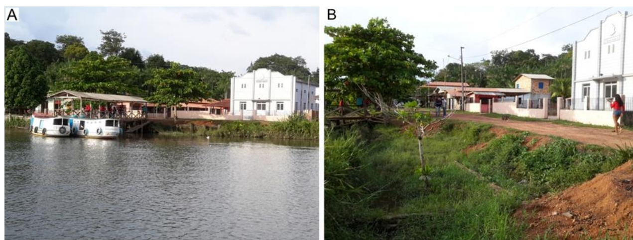
Figura 4 - (A) Frente da comunidade de São Lourenço. O avanço da erosão está atingindo a rua principal, igreja e posto de saúde. (B) Em detalhe os efeitos da erosão fluvial na orla da comunidade.
