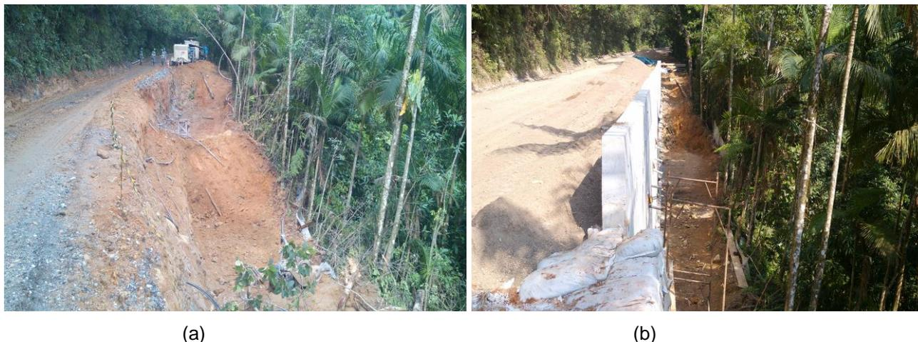
Figura 2. (a) Vista geral do escorregamento, (b) Vista geral recuperação de encosta com cortina atirantada.
