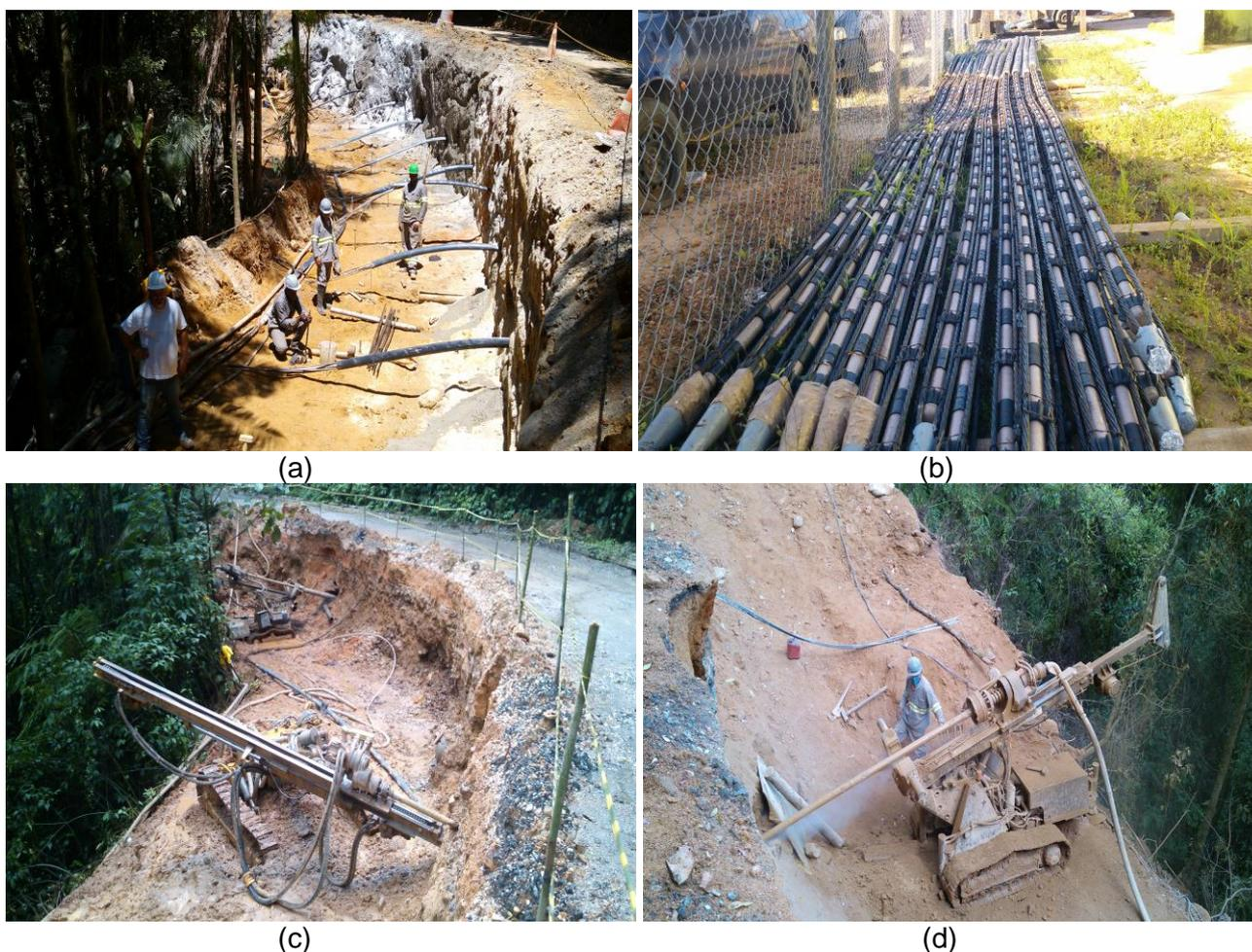
Figura 4. (a) Linha de tirantes, (b) vista geral detalhe da linha de tirantes, (c) detalhe de máquina apoiada em bermas, (d) perfuração com ar comprimido.
