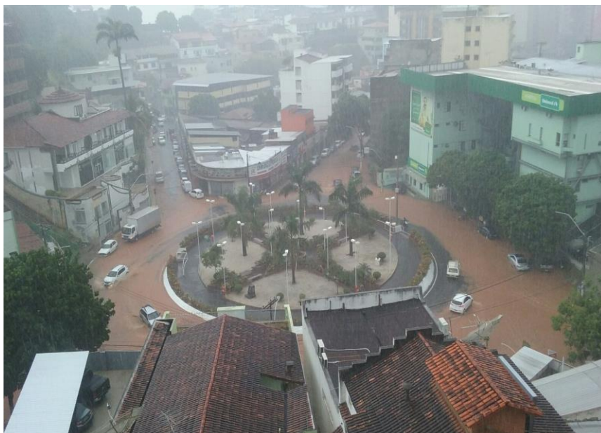
Figura 2. Vista geral do ponto de alagamento na divisa do Bairro Centro com o Bairro Gilberto Machado.
