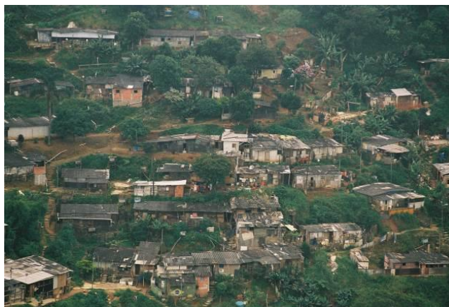
Figura 2: Encosta no bairro Jardim Silvina, moradias com baixo padrão construtivo, instaladas após a intervenção do tipo corte e aterro. (São Bernardo do Campo, 2010b).
