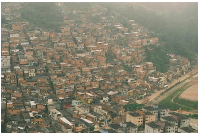
Figura 1: Encosta no bairro do Montanhão, ocupação de alta densidade ao longo da encosta. Terreno apresentando encosta predominantemente retilínea. (São Bernardo do Campo, 2010b).
