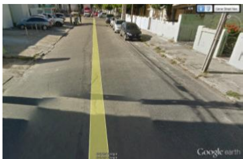
(a) Pavimento Asfáltico
