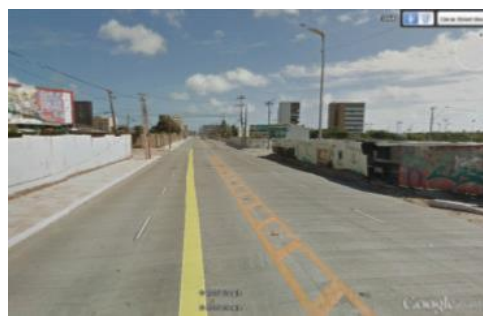
(b) Pavimento de Concreto
