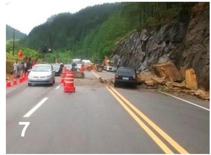
Figura 5 – Rompimento de talude no km 120 – março de 2016 (Portal Fotos Públicas, 2016).
