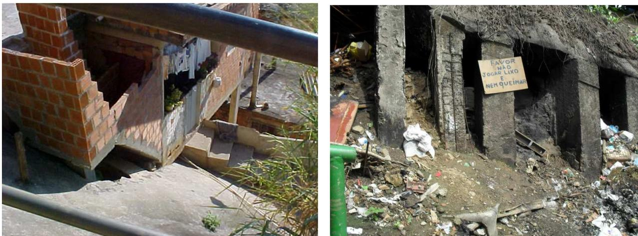
Figura 3 – Exemplos de depredações e construções sobre de obras de estabilização (Morro da Formiga à esquerda Salgueiro, à direita).
