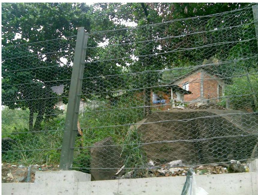
Figura 4 – Estrutura de impacto construída e casa a montante, cujo morador não aceitou oferta de reassentamento no Morro São João.
