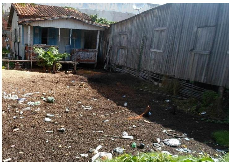
Figura 4. Materiais gárbicos de origem orgânica - são caroços de açaí utilizados como aterro na planície do Tucunduba.
