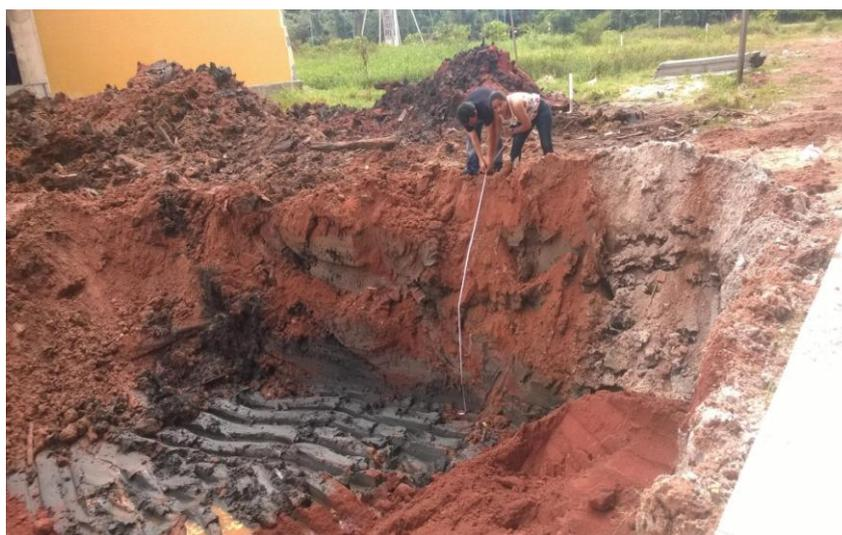
Figura 3. Vista da argila muito mole na base da planície e no topo material arenoso.
