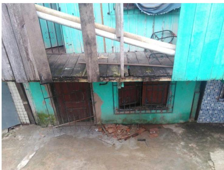
Figura 5. Moradias de baixa renda afetadas por processos de subsidências lenta ao longo de décadas que leva a perdas materiais permanentes na planície do Tucunduba.
