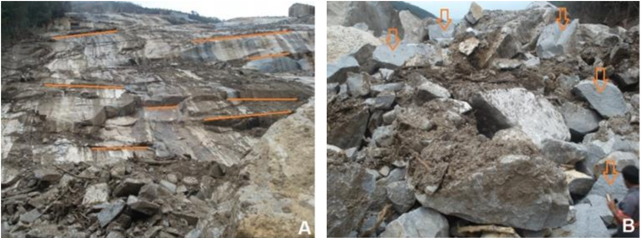
Figura 8: Vista frontal da cicatriz do escorregamento, mostrando estruturas Geológicas. Imagem A: orientação da principal família de fraturas; Imagem B: fraturas vivas em rochas sãs (setas alaranjadas). Fonte: Cosme/SABESP (22/11/2011).
