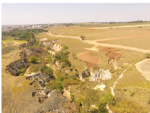
Figura 2. Vista parcial da erosão de jusante para montante.
