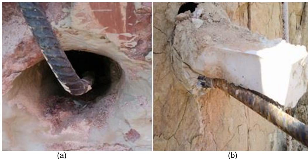
Figura 3. Verificação do preenchimento de calda dos grampos, (a) camada 2, (b) camada 3.
