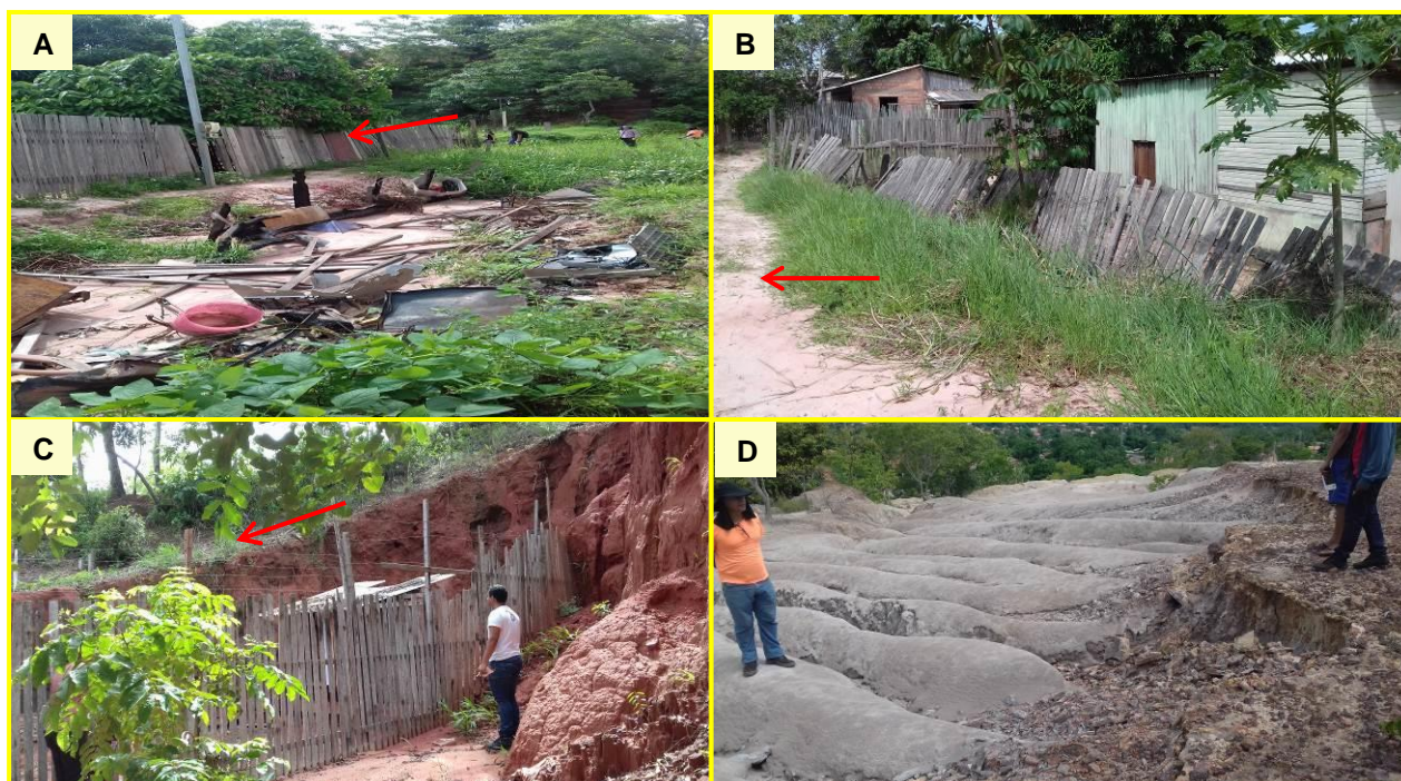
Figura 3: Pontos 6.1 e 6.2 – Bairro Amparo: (A) Inclinação de cerca da residência; (B) Seta indica a direção do sopé do morro; (C) Residência no sopé do morro; (D) Presença de crosta laterítica e ravinamentos.
