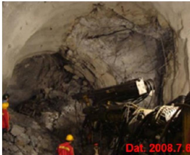
Figura 2. *Rockburst* em túnel auxiliar da usina hidrelétrica de Jinping, China. Fonte: Yan *et al.* (2015).
