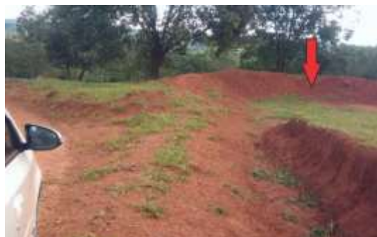
Figura 13. Bolsão de contenção de água pluvial margeando estrada posicionada em vertente com elevada declividade (seta).
